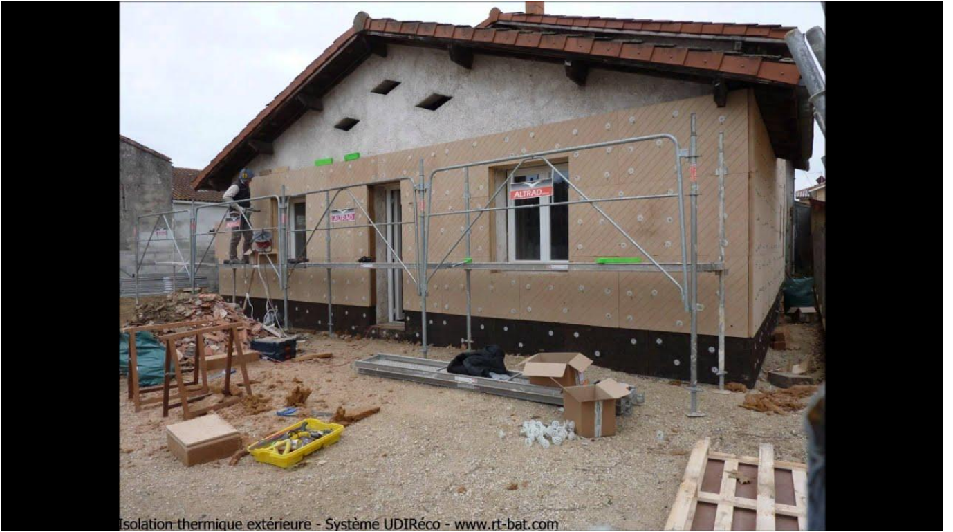
Isolation thermique extérieure - Système UDIRéco - www.rt-bat.com
