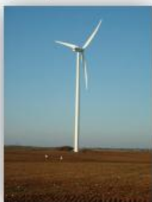
Eolienne de la ville de Benet (Photo The wind power)
