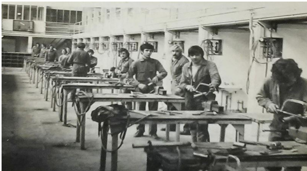
L'atelier de Plomberie avant sa Rénovation
