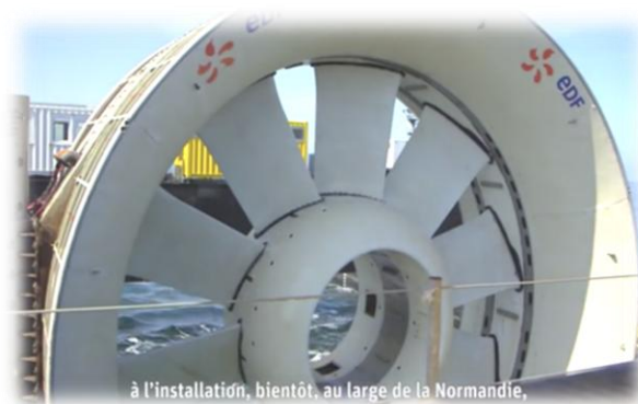
Hydrolienne en cours d'installation, au raz Blanchard
