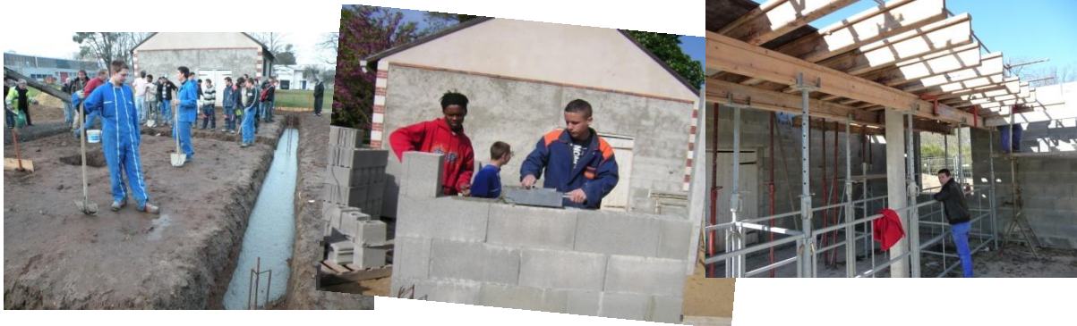
Construction des garages du lycée
