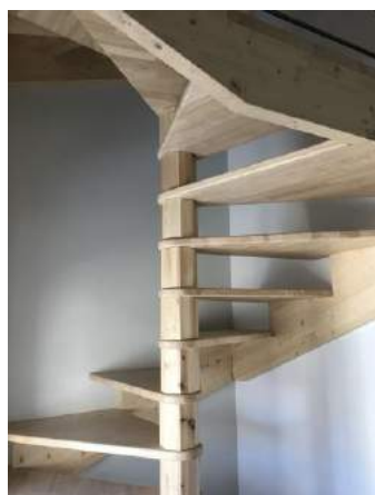
Escalier hélicoïdale
